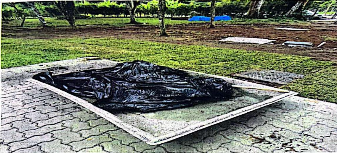
Figura 23. Cimento fresco para finalizar o reparo da rede de esgotamento sanitário.
